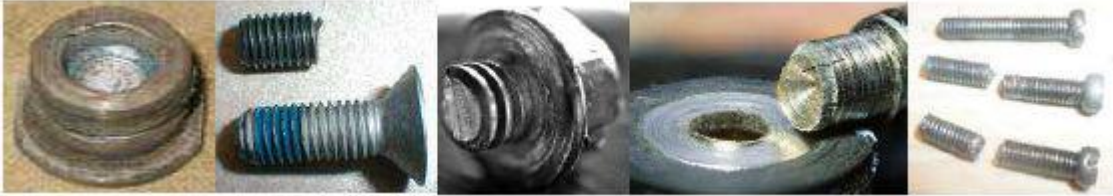
ਚਿੱਤਰ-24 ਟੁੱਟੇ ਅਤੇ ਖਰਾਬ ਪੇਚ
